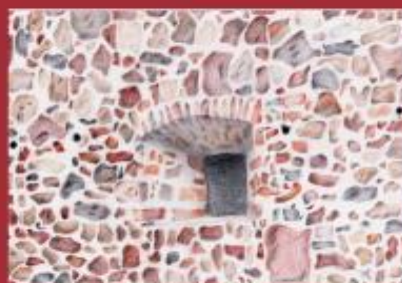
Stena vchodu dovnútra ohradenia
